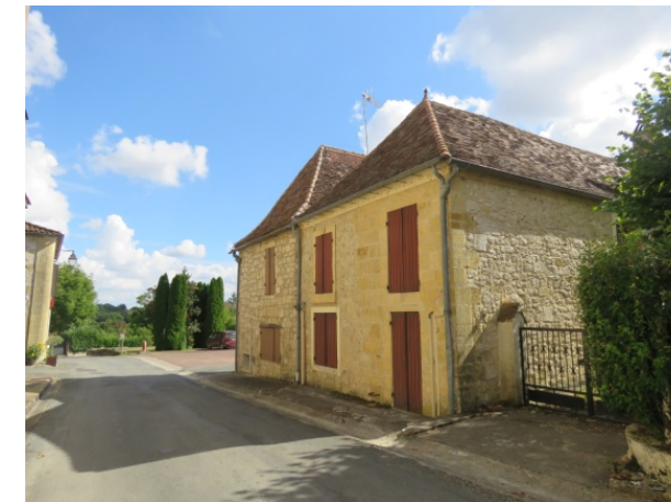
Toiture surmontée d'un épi de faitage
