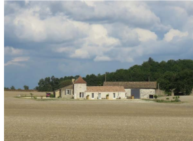
Construction mixte avec une tour couverte de tuiles plates et une extension récente couverte de tuiles canal
