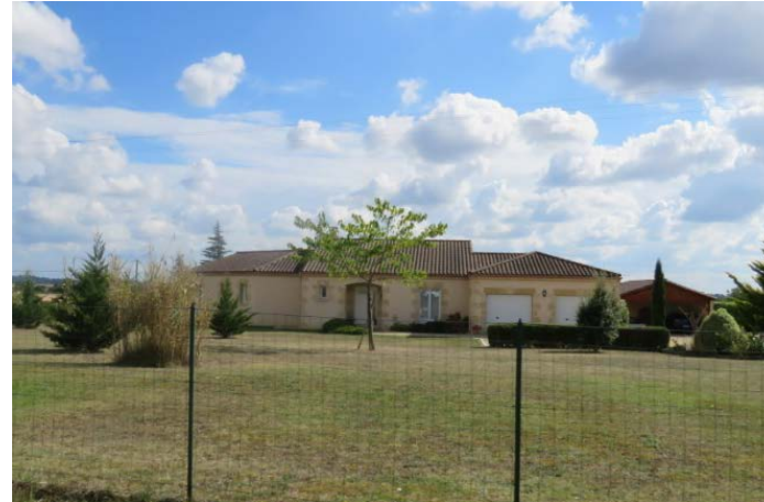
Construction récente à la façade enduite, à tuile canal, et dotée de chaînes d'angle
